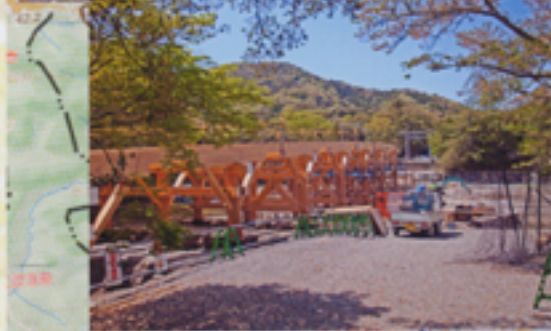
宇治橋架け替え工事
