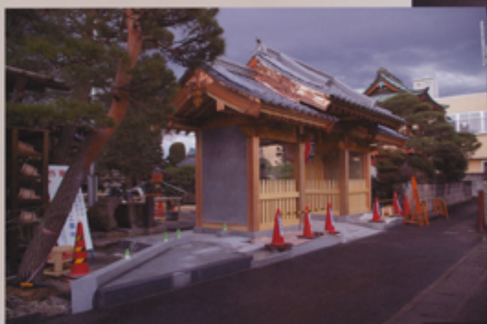
仁王門を鐘楼方向に見る
